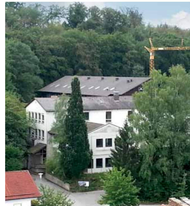
Das Noviziatsgebäude grenzt direkt an den alten Ortskern von Neuötting-Alzgern.
